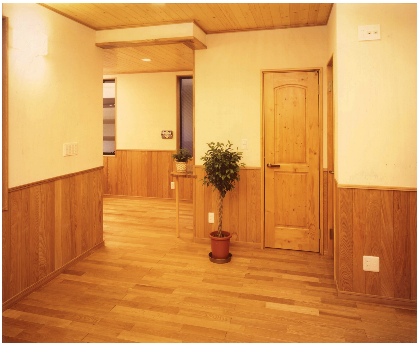
施工写真：オーク自然塗装仕上
